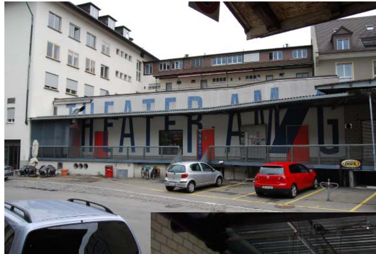
Fassade vor dem Umbau
