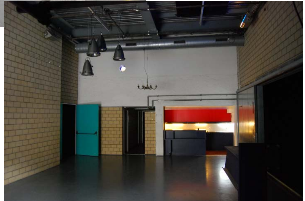
Foyer vor dem Umbau
